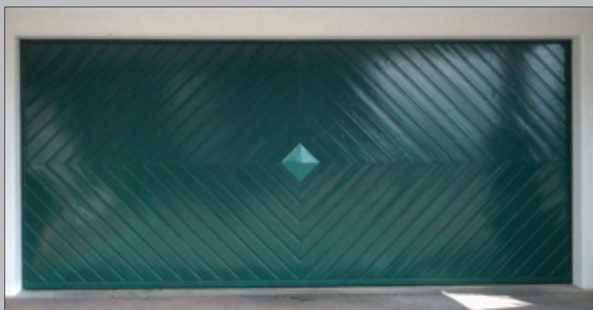
Kipptor aus Holz deckend gestrichen
