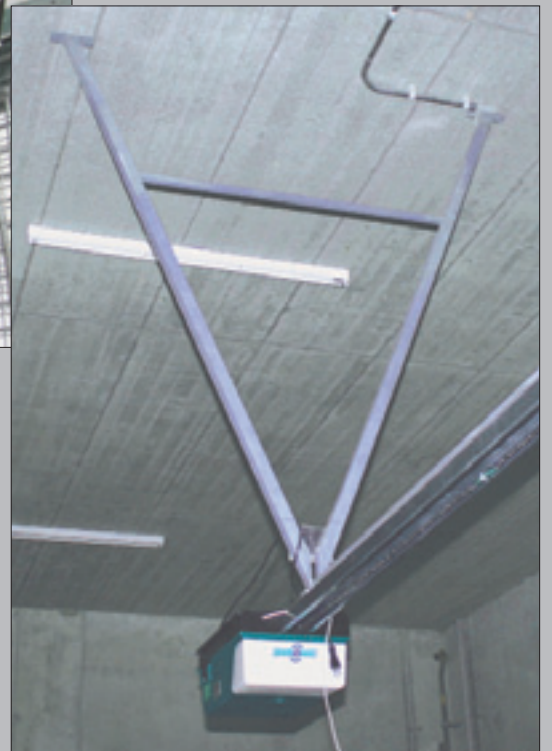
Garagentorantrieb mit spezieller Aufhängung
