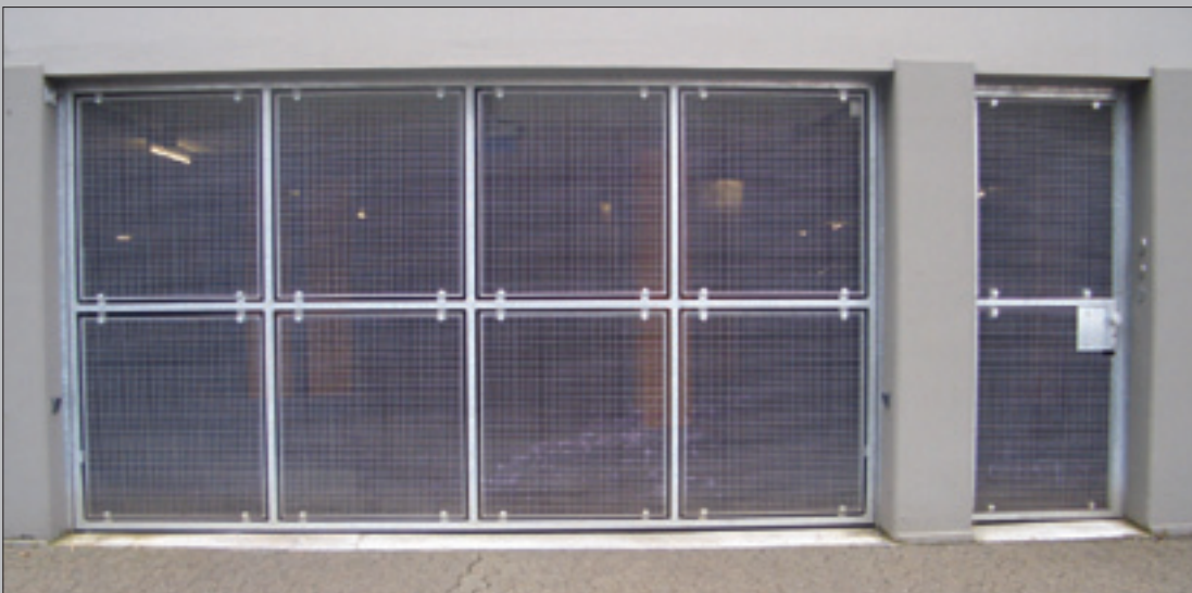
Schiebetor aus Lochblech mit separater Servicetüre
