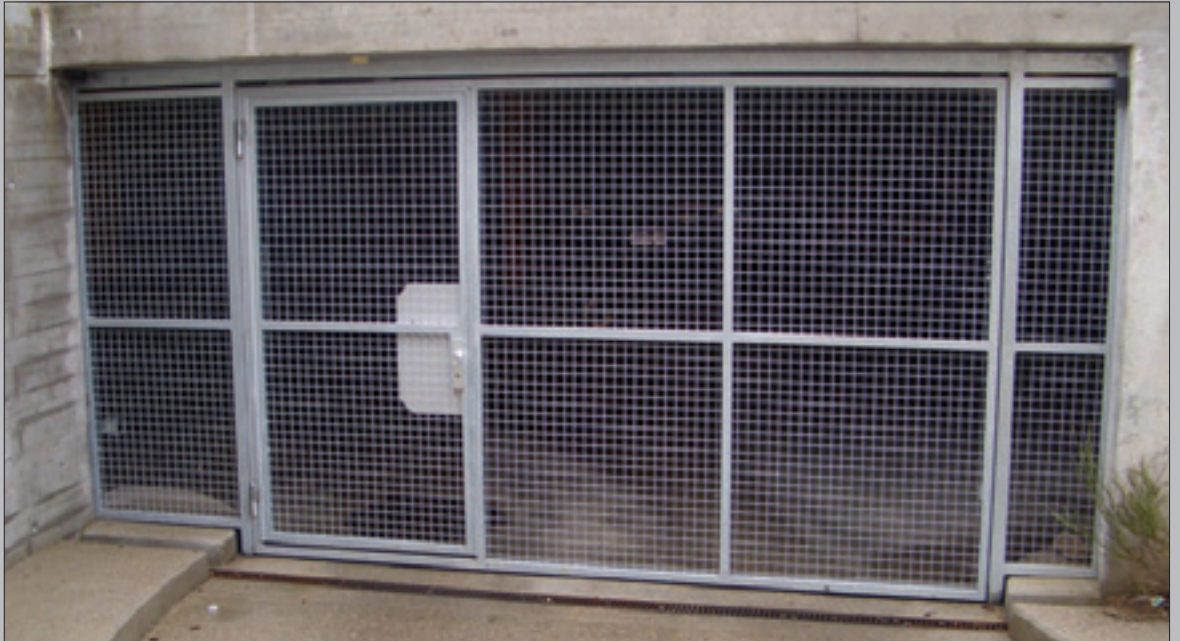
Kipptor aus Wellengitter inkl. Servicetüre auf Torblatt
